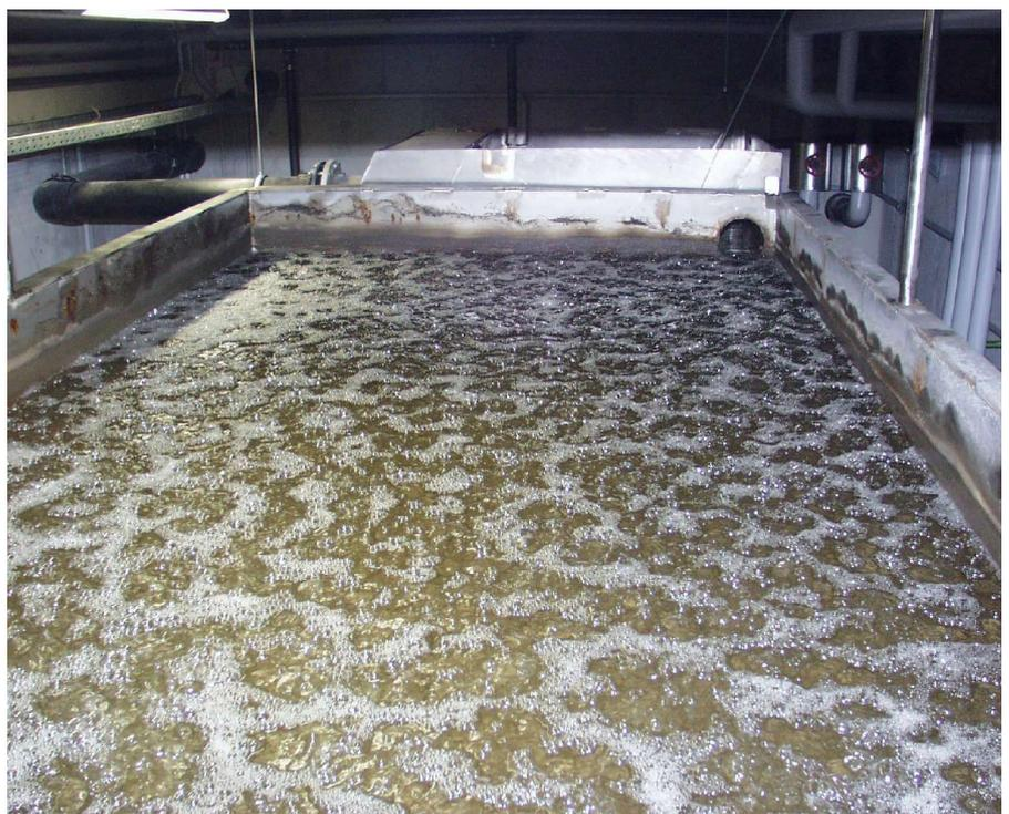
**Bild:** Blick auf die Oberfläche einer oberirdisch aufgestellten Biostufe
